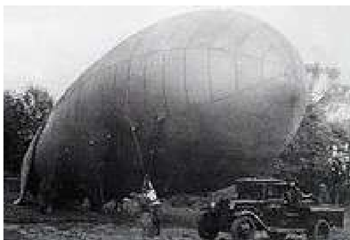
Рисунок 2 – Установка аэростата воздушного заграждения
